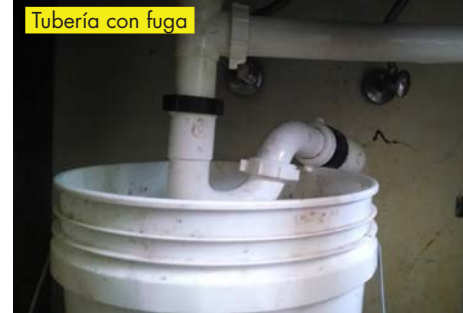
Tubería con fuga
